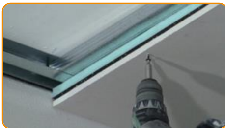
Fissare il pannello Mustwall B ai profili metallici con viti da 55 mm ogni 15 cm
