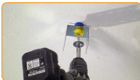
Forare il soffitto e fissare il gancio isolante
